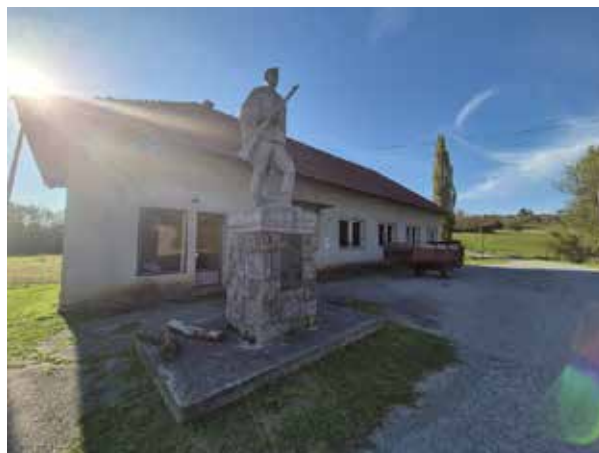
Slika 105. Društveni dom u Miljanovcu, izvor: Level Project d.o.o.
