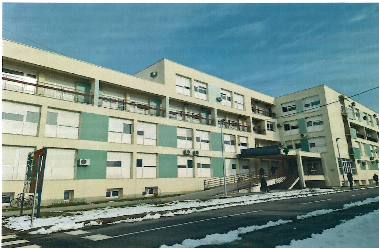
Slika br.1.: Energetski obnovljena zgrada tzv. „Nove bolnice“
