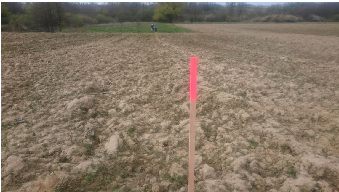
Slika 4.3-1: Geodetsko iskolčenje profila (završni kolac na profilu GEL -1)
