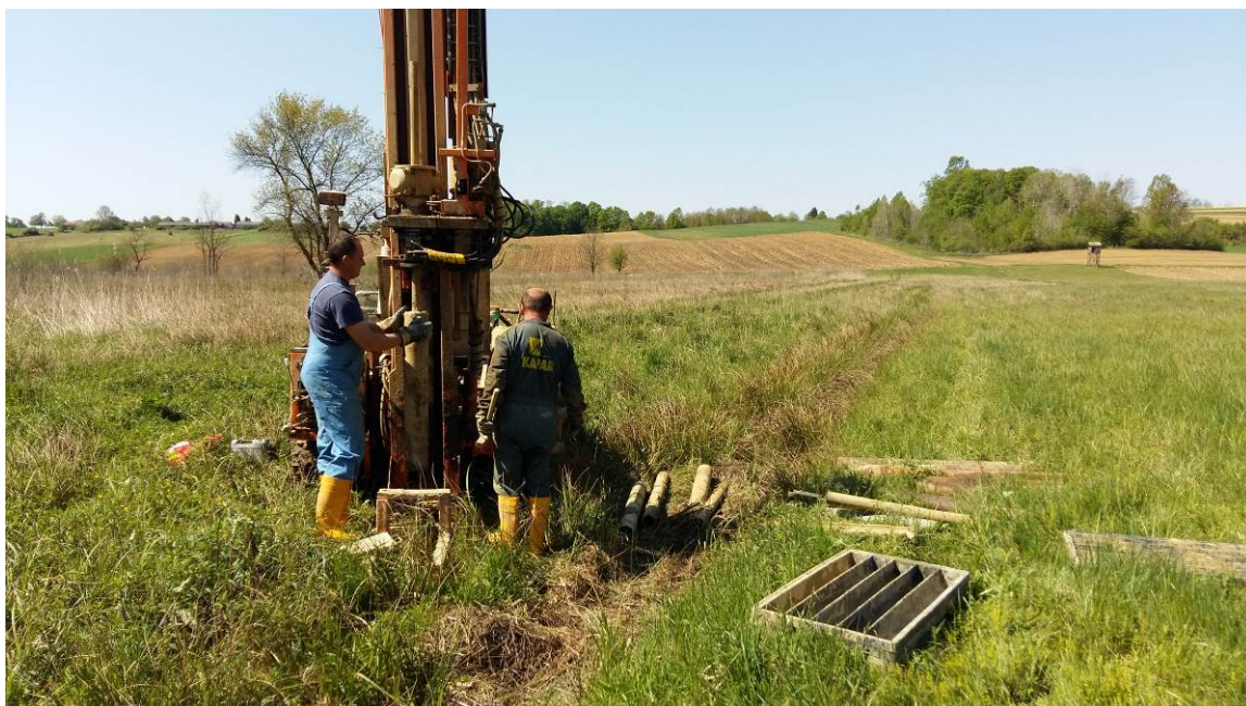
Slika 4.3-4: Provođenje istražnog bušenja (bušotina G2-B2)
