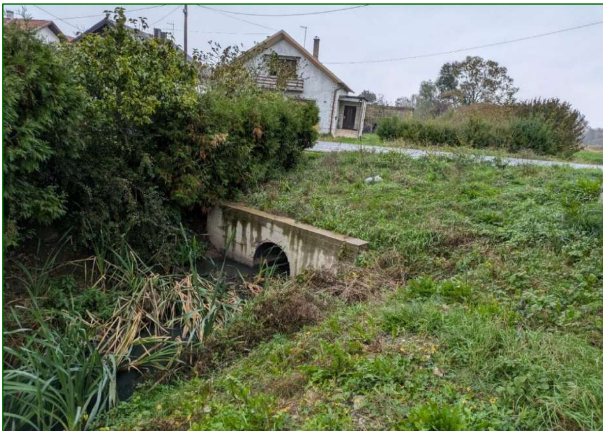
Slika 8. Pogled uzvodno na propust u stacionaži u km 0+535 (Izvor: Grad Invest d.o.o.)
