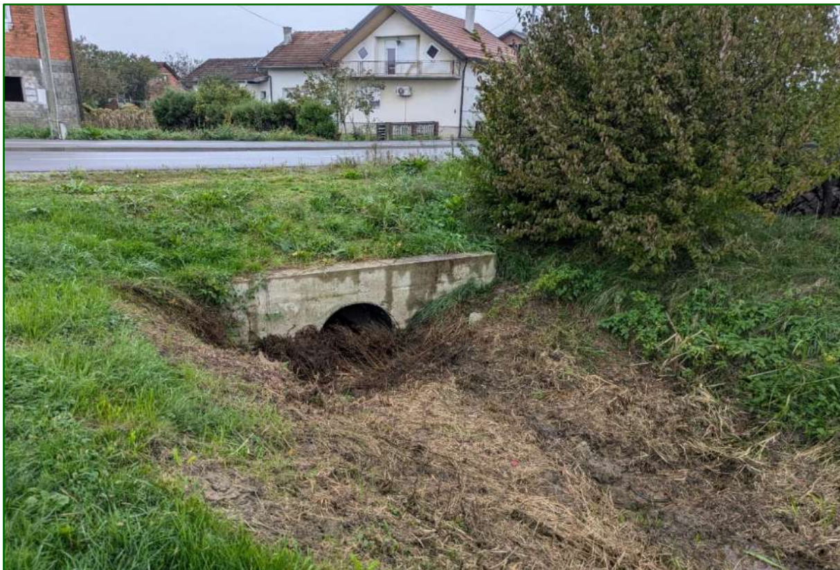
Slika 7. Pogled nizvodno na propust u stacionaži km 0+559 (Izvor: Grad Invest d.o.o.)
