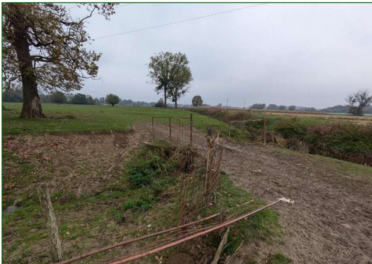
Slika 13. Pogled na postojeći drveni propust u stacionaži km 0+116 (Izvor: Grad Invest d.o.o.)
