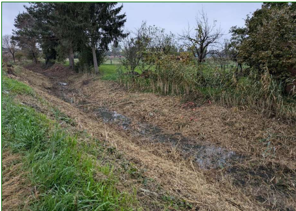
Slika 10. Pogled nizvodno od stacionaže km 0+500 (Izvor: Grad Invest d.o.o.)
