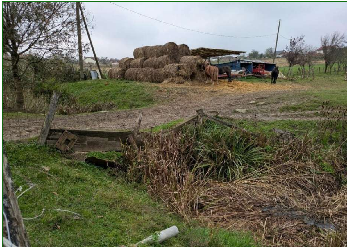
Slika 11. Pogled na postojeći drveni propust u stacionaži km 0+296 (Izvor: Grad Invest d.o.o.)
