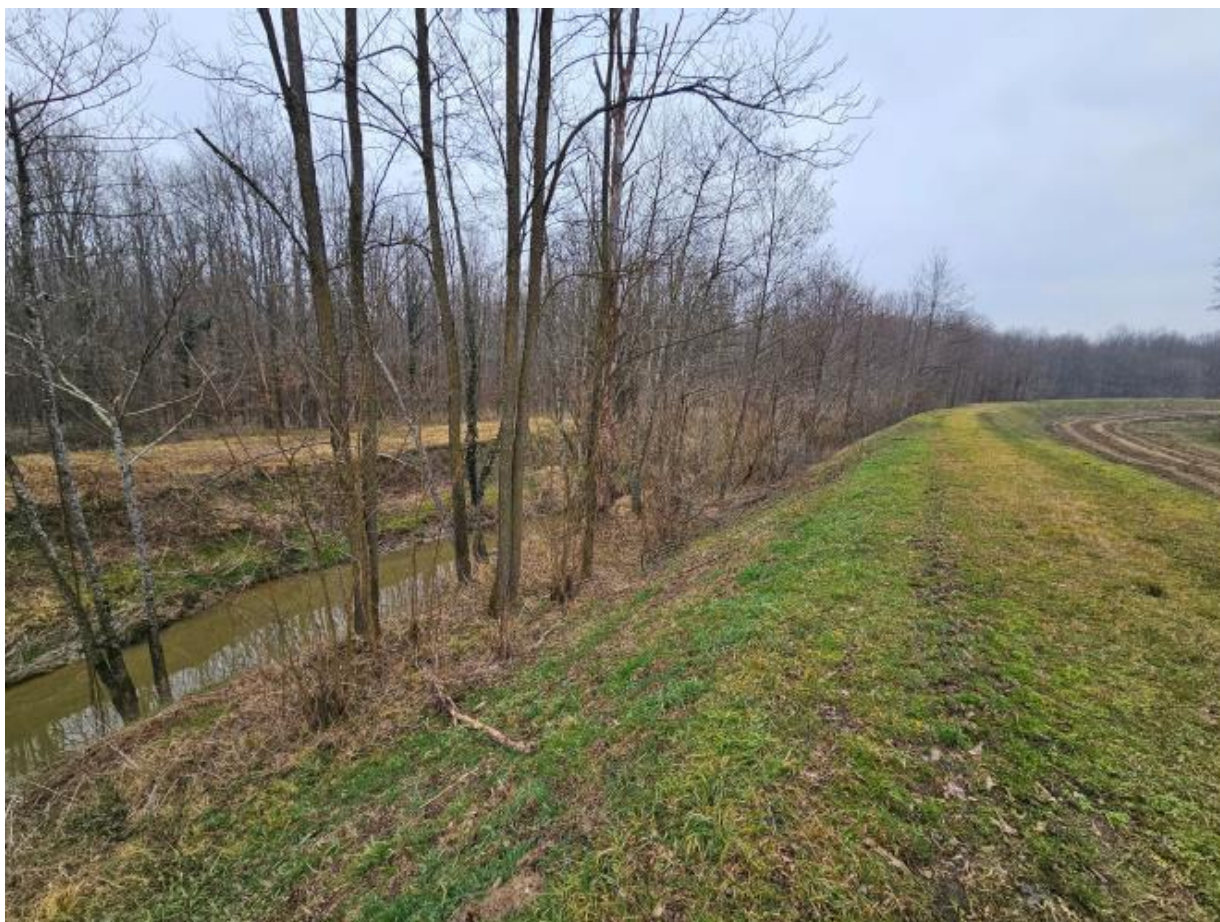
Slika 1.6 Prikaz postojećeg nasipa na lijevoj obali vodotoka Grabovnica, vodotok Grabovnica i desna obala na kojoj će bit izveden novi nasip
