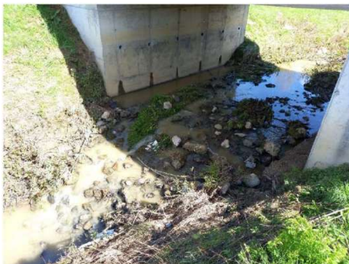
Slika 1.1.1.4. Vučeni nanosi ispod cestovnog mosta, rkm 16+545
