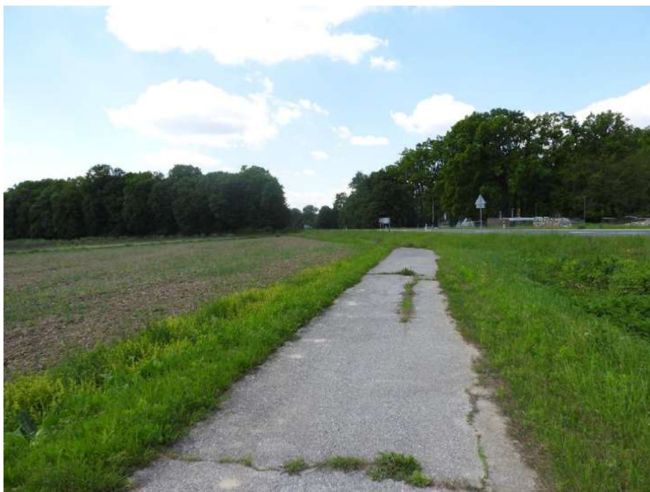
Fotografija C-24: Početak trase planirane prometnice i spoj na državnu cestu DC28, oko stacionaže 0+000, pogled prema sjeverozapadu Izvor: Terenski obilazak
