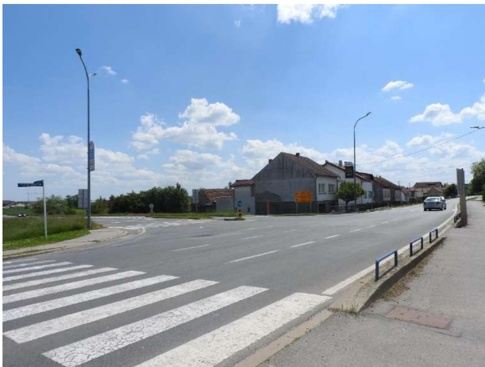
Fotografija C-37: Kraj dionice DC28 – DC43 te postojeće državne ceste DC43 i DC548, oko stacionaže 6+662, pogled prema istoku
