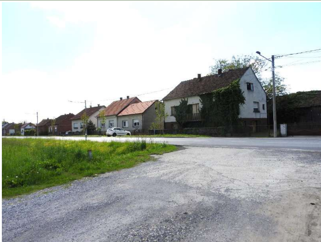
Fotografija C-30: Lokacija planiranog kružnog raskrižja na državnoj cesti DC318, oko stacionaže 3+000
