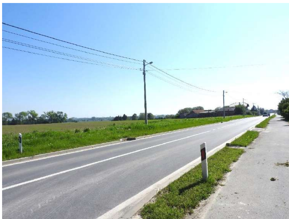
Fotografija C-41: Kraj trase dionice Stare Plavnice – DC544 te postojeća državna cesta DC544, oko stacionaže 1+265, pogled prema istoku
