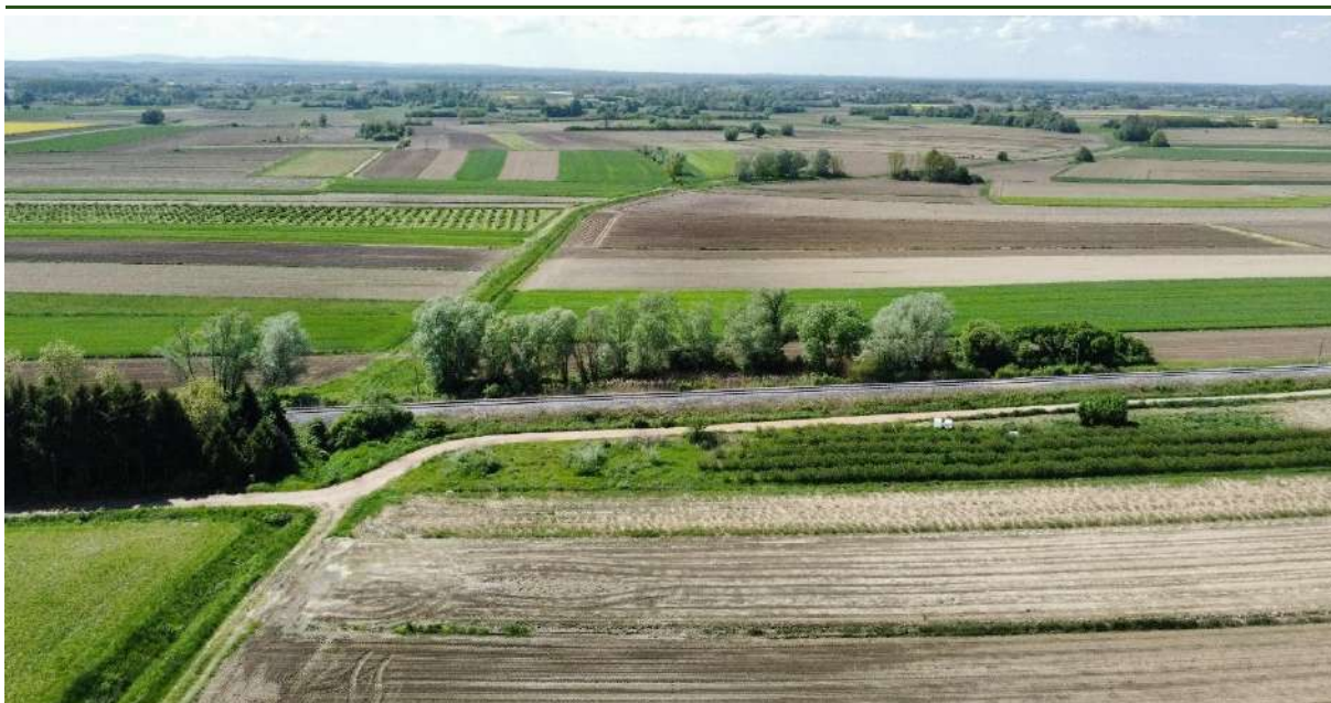
Fotografija 19: Pogled iz zraka na željezničku prugu za lokalni promet L203 (Križevci – Bjelovar – Kloštar), linijski potez visoke vegetacije i vodotok Plavnica od stacionaže 3+750 do 4+250
