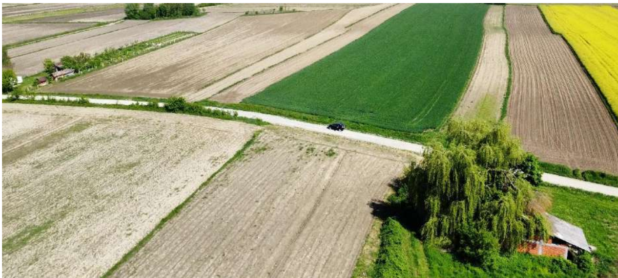
Fotografija 20: Pogled iz zraka na nerazvrstanu cestu, poljoprivredne površine, objekte istočno i zapadno od planirane prometnice od stacionaže 4+000 do 5+000
