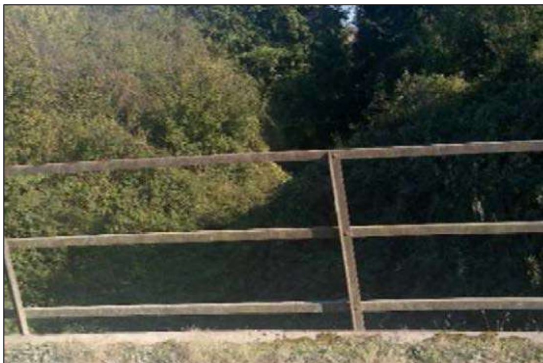
Slika 11. Propust kod Bulinca
