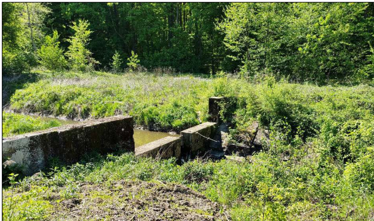
Slika 17. Na stacionaži oko km 8+930 nalazi se pregrada
