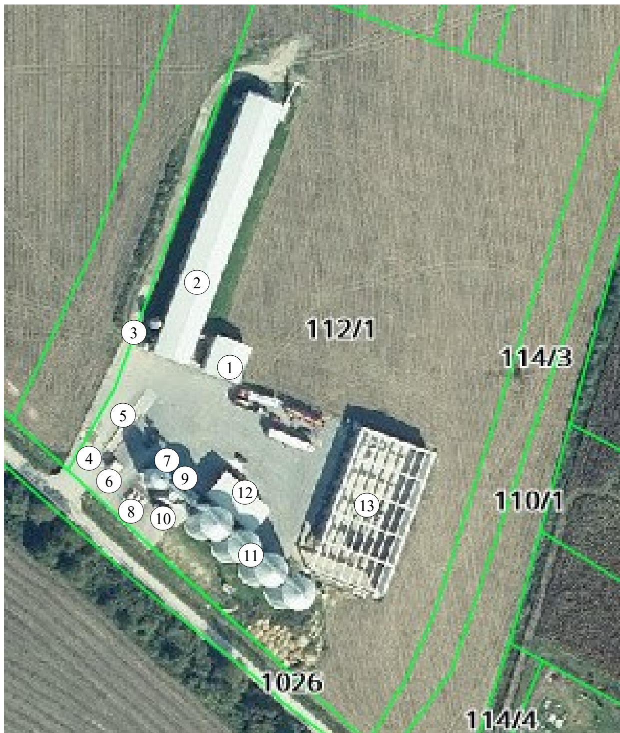
Slika 2. Postojeće građevine farme
