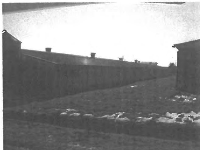
Izgled objekta za tov svinja
