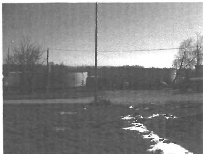
Bioplinsko postrojenje u izgradnji
